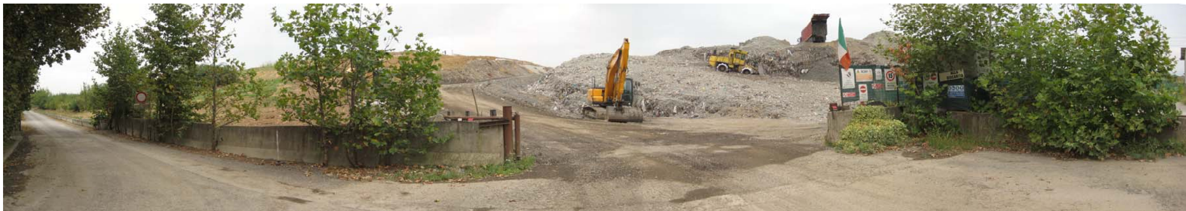
Discarica Bergamo Pulita di Cavernago. Vista ingresso lato Est
