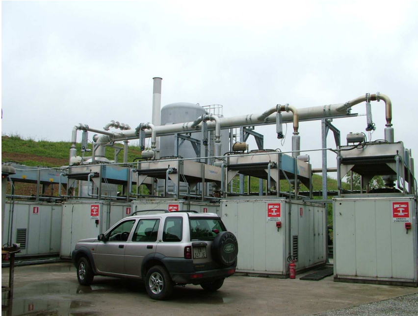
Fotografia 1: Impianto di raccolta e ossidazione catalitica dei fumi di combustione del biogas
