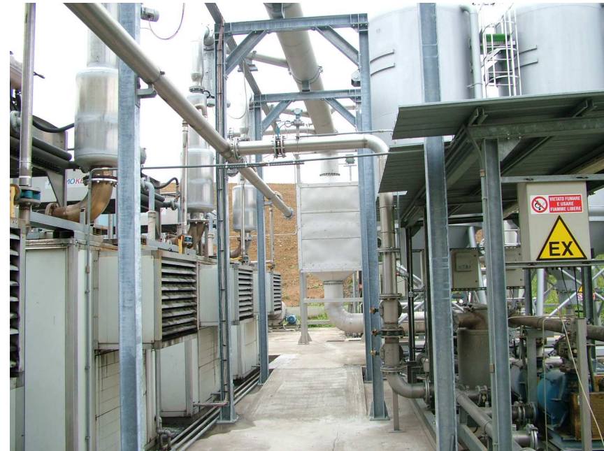
Fotografia 1: Impianto di raccolta e ossidazione catalitica dei fumi di combustione del biogas
