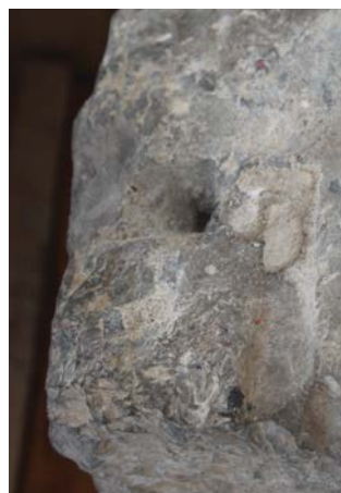
Parte superiore della lastra verso gli angoli con i fori per l'alloggiamento delle zanche
