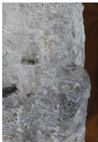
Parte superiore della lastra verso gli angoli con i fori per l'alloggiamento delle zanche
