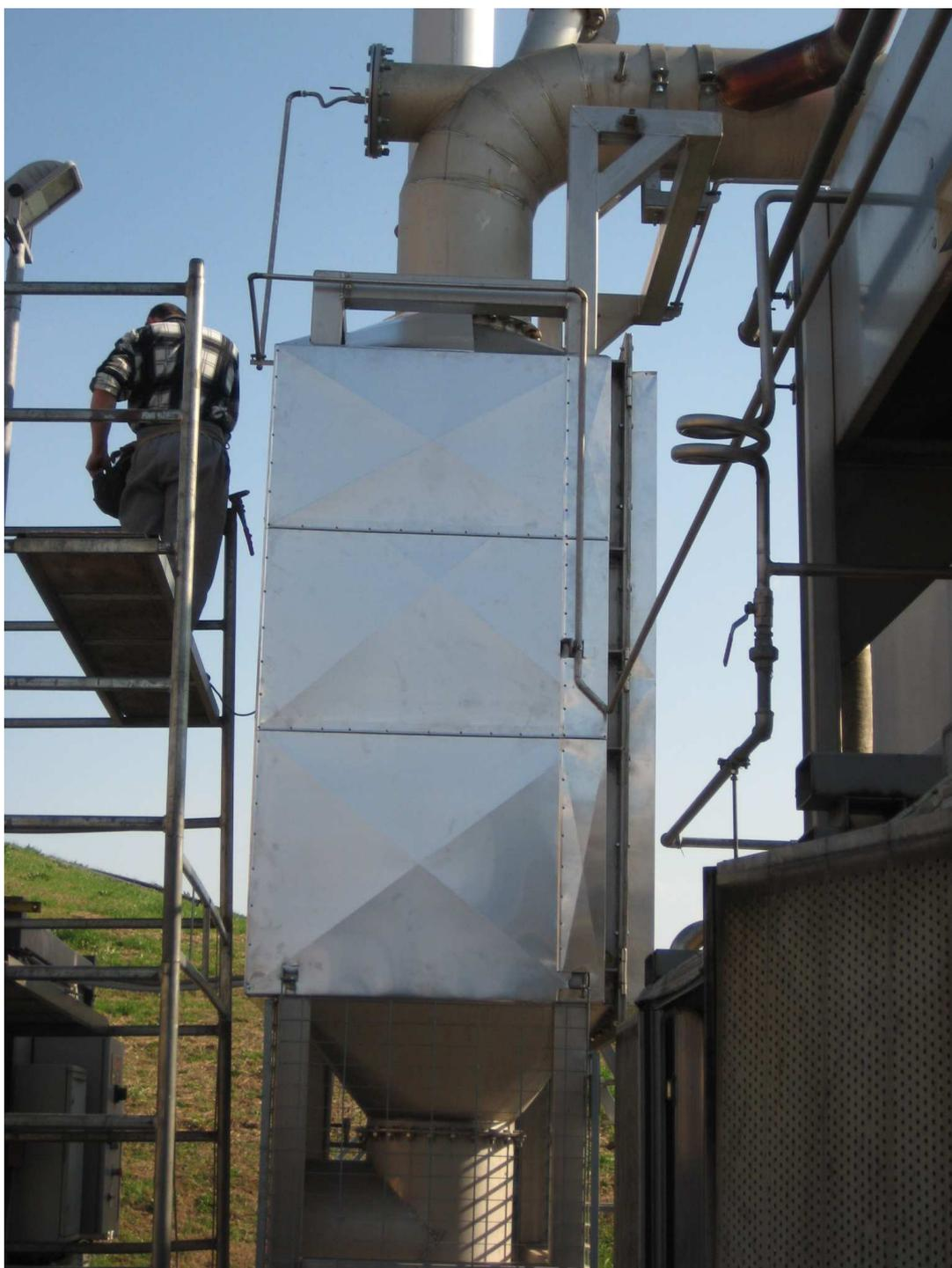
Foto 2. Interventi di isolamento termico della sezione DeNox di tipo SCR.
