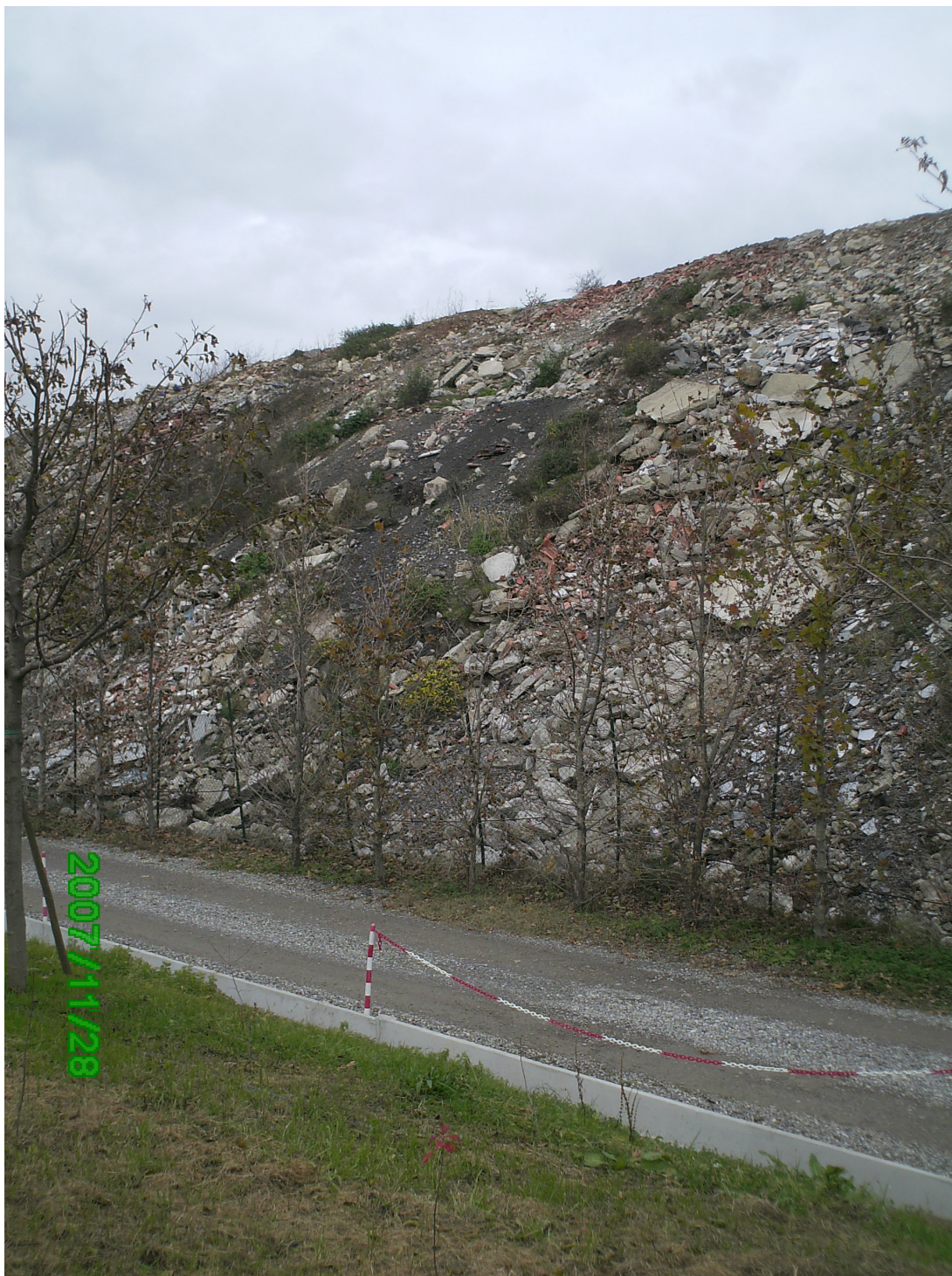
Foto 3b - confine con la proprietà Locatelli S.p.A. in Calcinato
