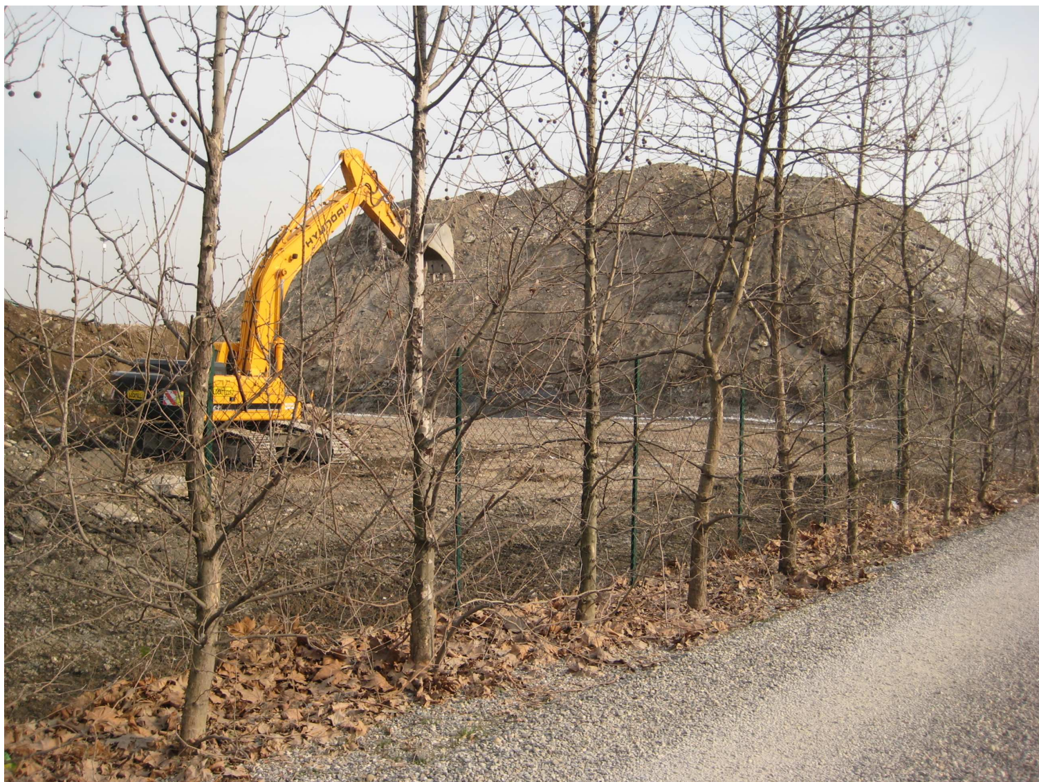
FOTOGRAFIA 2 – Impresa Locatelli procede alla rimozione dei cumuli di rifiuti lungo il confine SUD-Est
