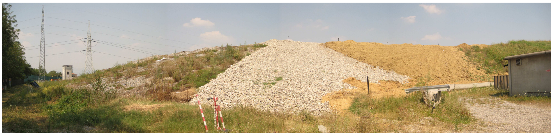
Fotografia 2: Stato del ripristino della scarpata Ovest – fronte impianto Biogas
