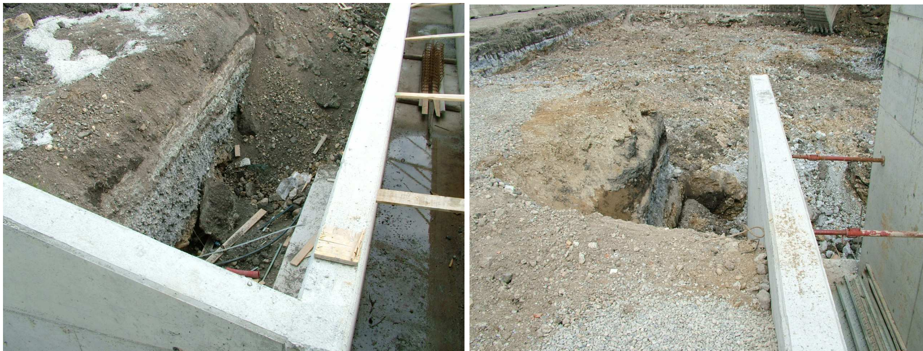
FOTOGRAFIA 3 – Strato di scorie di acciaieria emersi negli scavi dell’Impresa Locatelli
