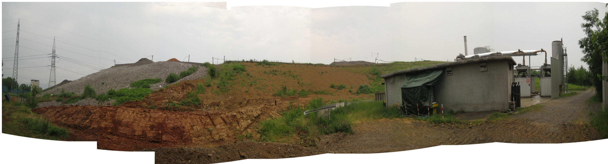
Foto 2. Vista del lato Ovest – impianto generazione elettrica da biogas
