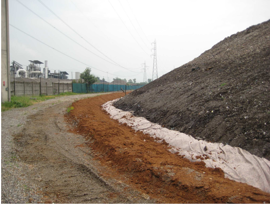
Foto 3. Copertura con geotessile del lotto 7
