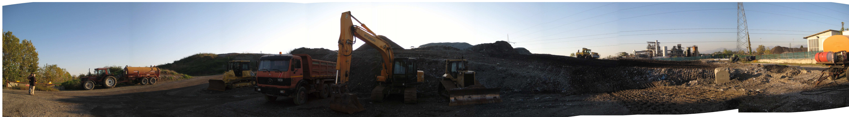
Figura 1. Vista dell'ingresso della discarica
