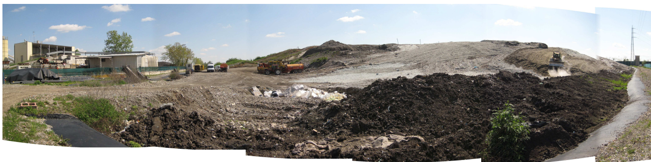
Foto 1. Lotto in fase di completamento
