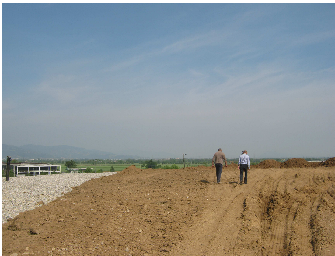
Foto 2. Ricopertura con inerte drenante e terreno di coltivo della sommità
