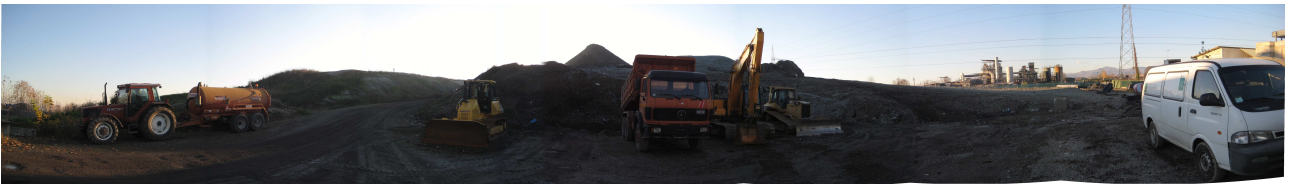
Fotografia 2. Vista da NordEst – Ingresso (6.12.2012)
