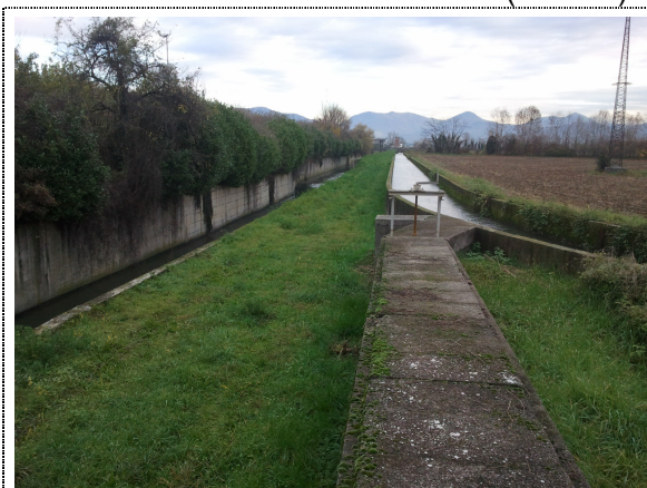
Foto 1: Scolmatore torrente Zerra (a sinistra) e Tubazione Speranzina (canale tombinato)
