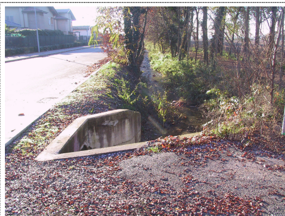
Foto 5: Fosso Mornichello all'uscita del tratto intubato nei pressi dell'incrocio tra via Ungaretti e via Rogge Colleonesche
