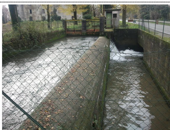
Foto 2: scolmatore del Ramo Malpaga lungo l'omonima via.
