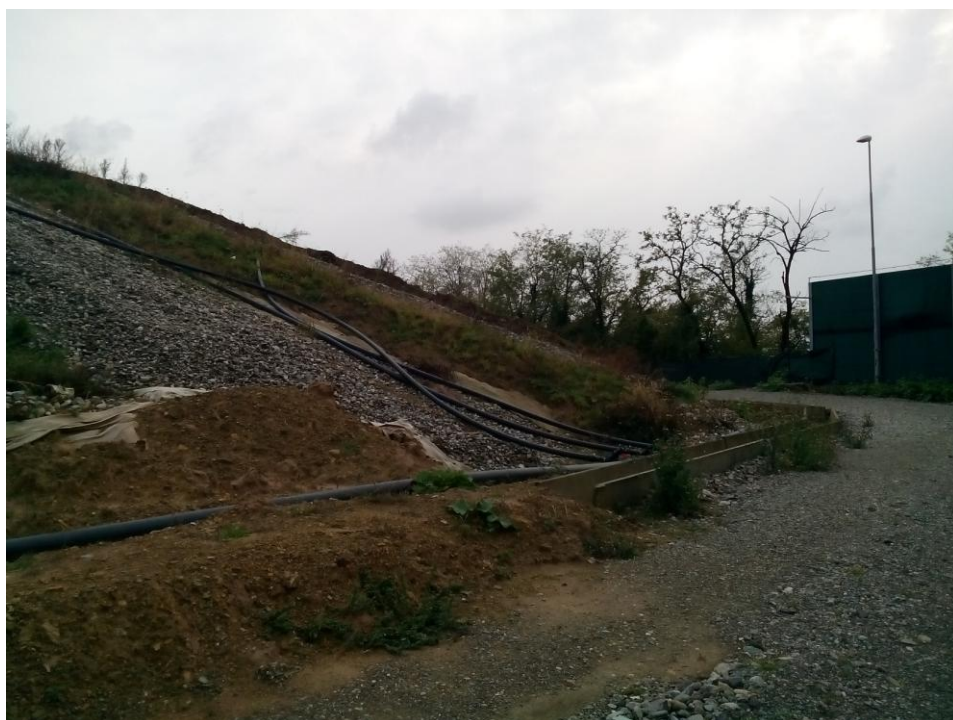
Fotografia 3: Versante Nord - vista verso Ovest
