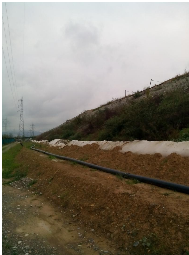
Fotografia 4: Versante Nord - vista verso Sud
