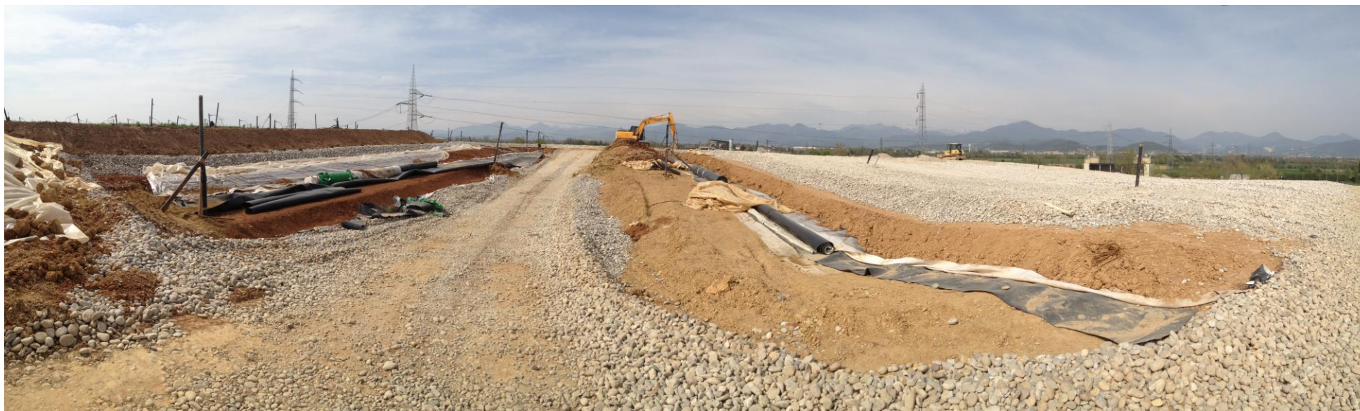
Fotografia 1: Stato della copertura in sommità dei lotti 5, 6, 7
