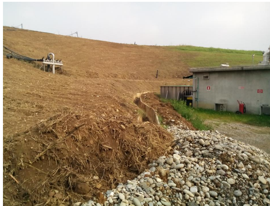
Fotografia 3: Versante Ovest - verso est
