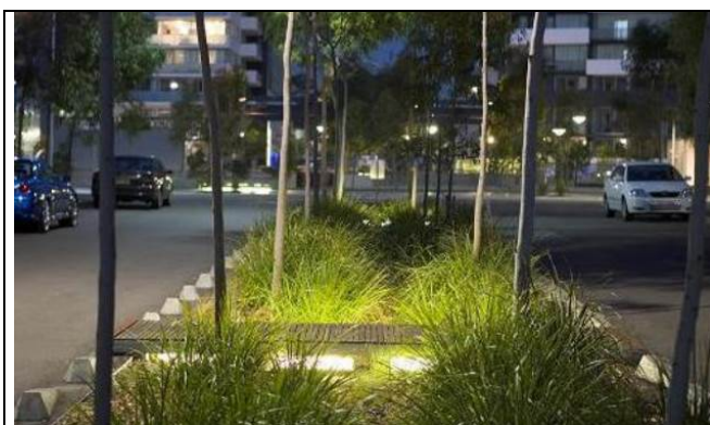
Foto 5: Esempio di fosso vegetato presso Victoria Park, Sydney (AUS), immagine tratta da "Manuale di drenaggio urbano".
