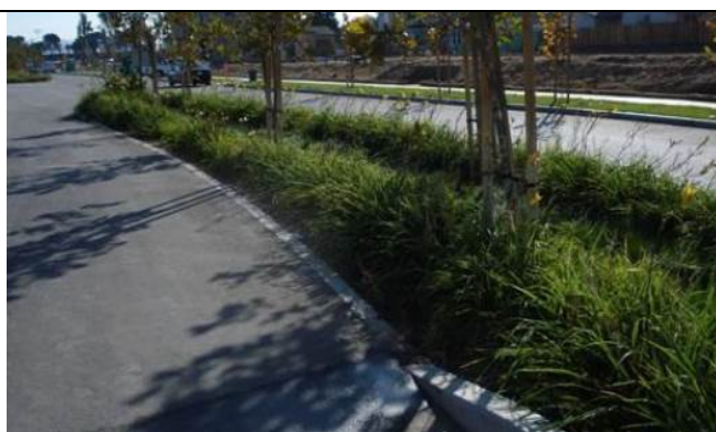
Foto 6: Esempio di fosso vegetato presso Livermore, California (USA), immagine tratta da "Manuale di drenaggio urbano".
