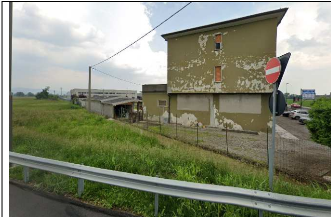
Foto 1: Cortile dell'abitazione posto sotto il piano stradale della SS 498.
