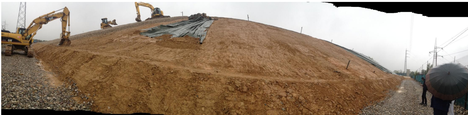
Fotografia 3: Scarpata Nord con applicazione strato drenante sopra l'argilla.
