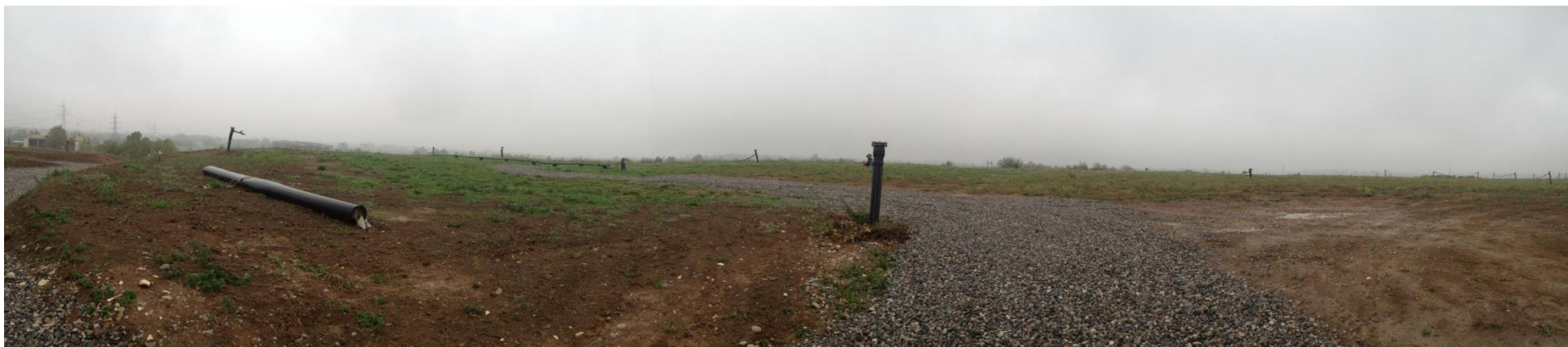
Fotografia 2a: Sommità con strato di coltivo ed inerbimento.
