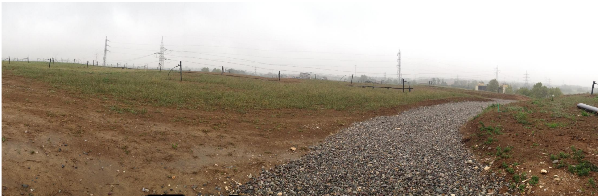
Fotografia 2b: Sommità con strato di coltivo ed inerbimento.
